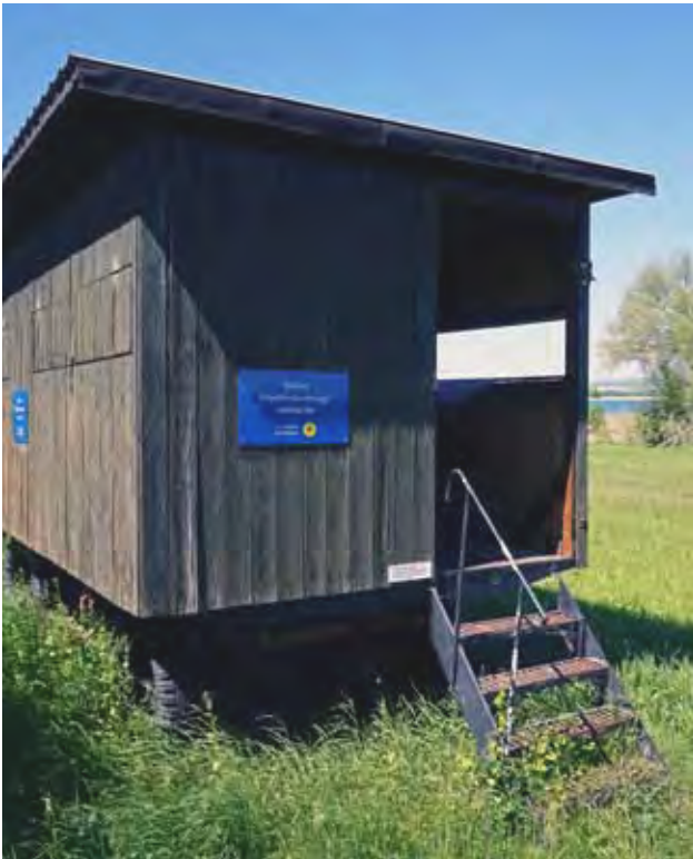
56 Die mobile Vogelbeobachtungsstation befindet sich unterhalb des Mittelbergs (J. JEDICKE 2018).
